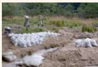
砂が湿原に流入しないように湿原手前に沈砂池を作って砂を溜めている。満杯になると、砂を土のう袋に詰めて沢の補強や堰堤づくりなどに利用する
