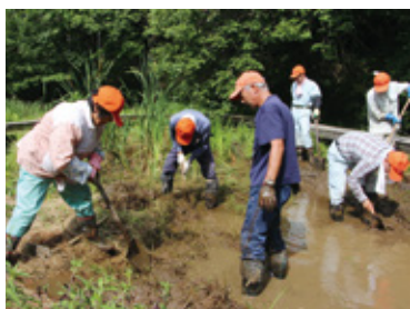
沼地の泥上げ。一度荒れた里山を復元するには地道な作業が必要だ
