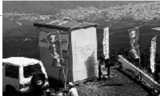
し尿問題解決へ、バイオトイレを設置 観光客や登山客の残す大量のし尿を処理、解決する試みとしてバイオトイレを設置。杉チップを利用し、微生物がし尿を炭酸ガスと水に分解、自然蒸発させ、水をトイレ槽内でリサイクル使用できる完全循環型トイレです。(NPO法人 富士山クラブ主催)
