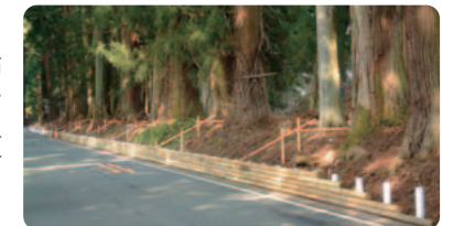
木柵を作り土を施すことで、露出した杉の根を保護
