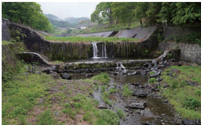
1級河川の雄川。雄川堰は、この雄川の中流部から取水している
