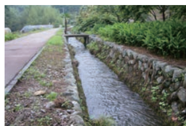
取水口付近の大堰
