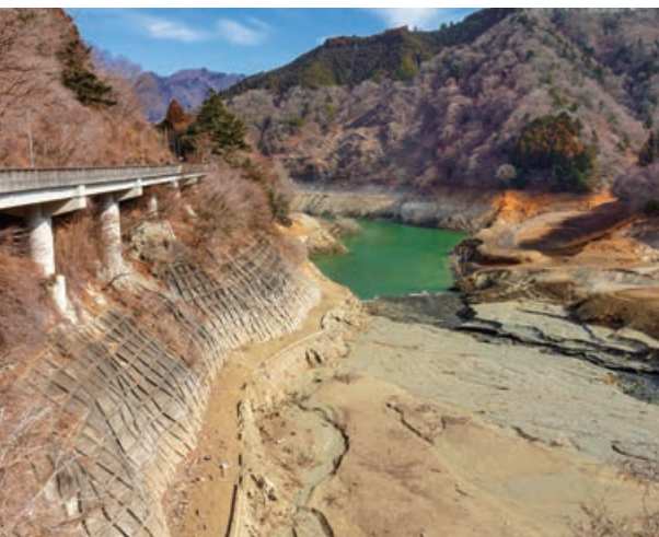
水位が低下した神奈川県宮ヶ瀬湖。かつての道路が現れた
