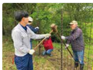
鹿防止柵設置
